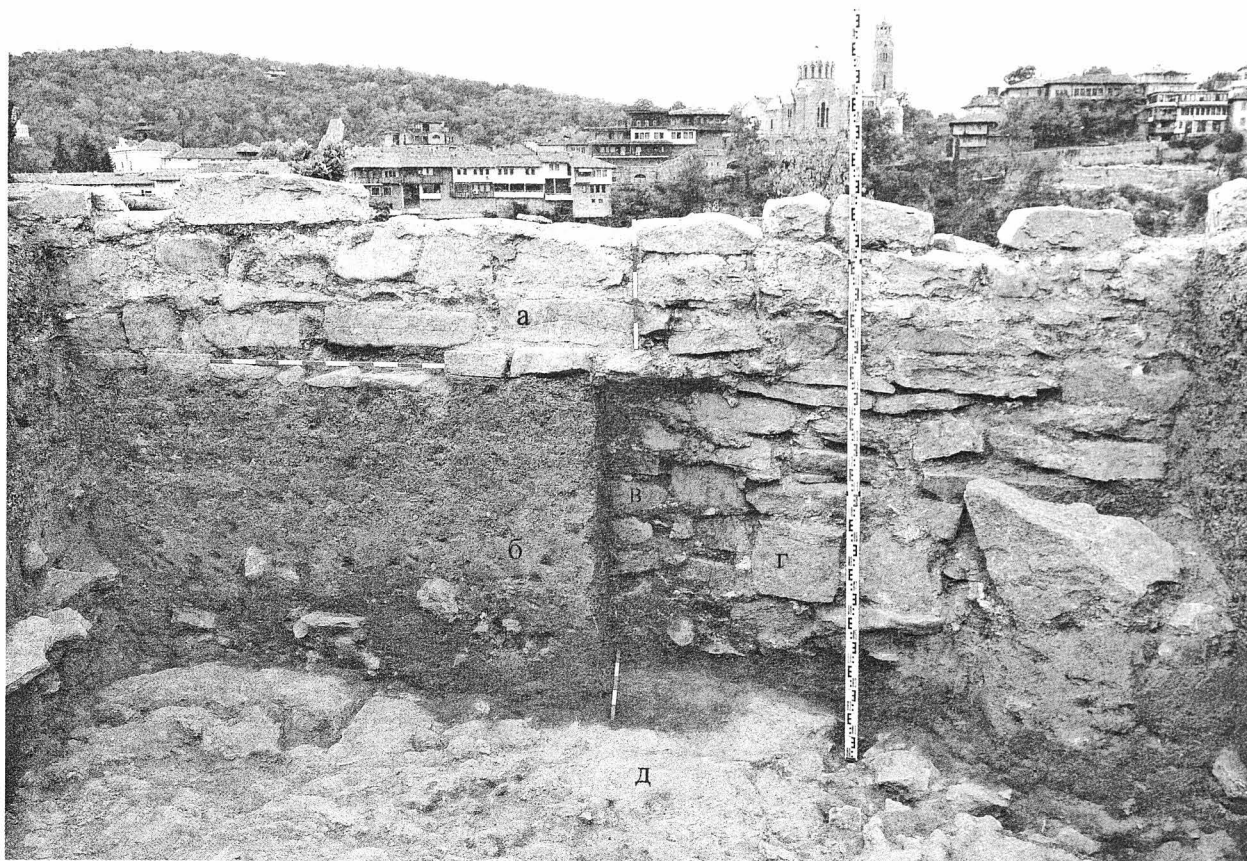
Обр. 9. Трапезица, Велико Търново. Основите на крепостната стена – изглед от север: а - суперструкция на стената; б - нивелиращ пласт; в, г - различаващата се по градеж субструкция на стената; д - материковата скала Fig. 9. Trapezitsa, Veliko Tarnovo. Foundations of the fortification wall – view from the north: a - superstructure of the wall; b - leveling layer; c, d - different building techniques of the sub-structure of the wall; e - the bedrock
