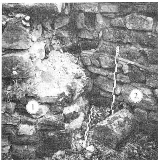
Обр. 7. Търновград. Подпорна стена и връзката ѝ със северозападния ъгъл на водохранилището Легенда: 1. Северозападен ъгъл на водохранилището; 2. Подпорна стена
